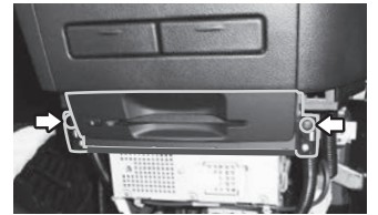
図4 AVユニットカバー取り外し
